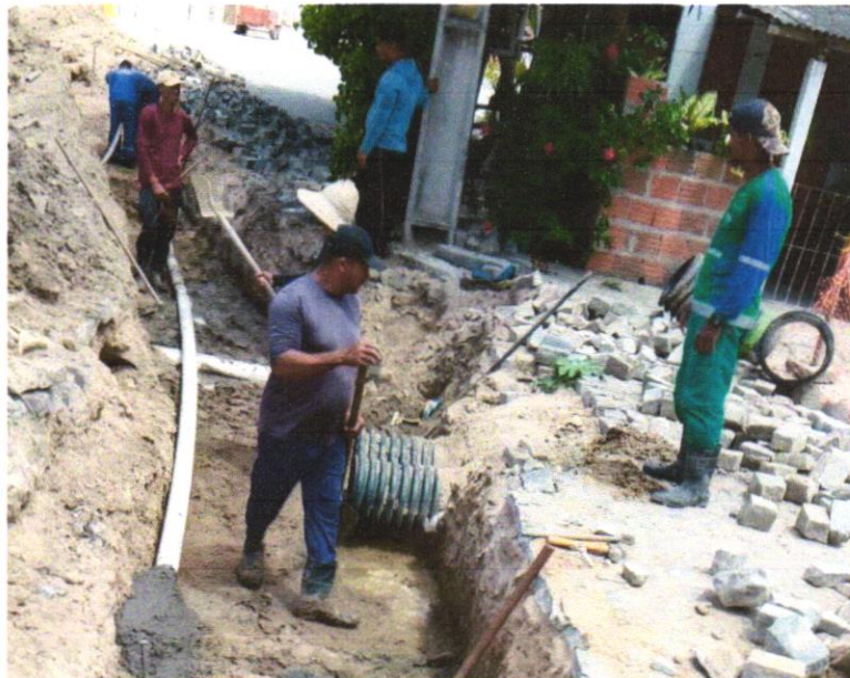
Foto 02 – ESCAVAÇÃO DE VALA
