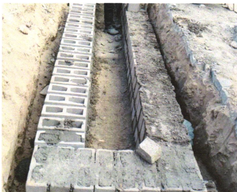
Foto 06 – ALVENARIA DE BLOCOS DE CONCRETO ESTRUTURAL 14X19X39 CM, (ESPESSURA 14 CM) FBK = 14,0 MPA, PARA PAREDES COM ÁREA LÍQUIDA MENOR QUE 6M², SEM VÃOS, UTILIZANDO PALHETA. AF_12/2014
