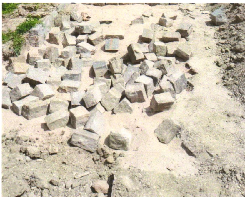
Foto 04 - ATERRO MANUAL COM SOLO ARGILO-ARENOSO IMPORTADO E COMPACTAÇÃO MECANIZADA EM CAMADAS DE 0,20 M NO MÁXIMO
