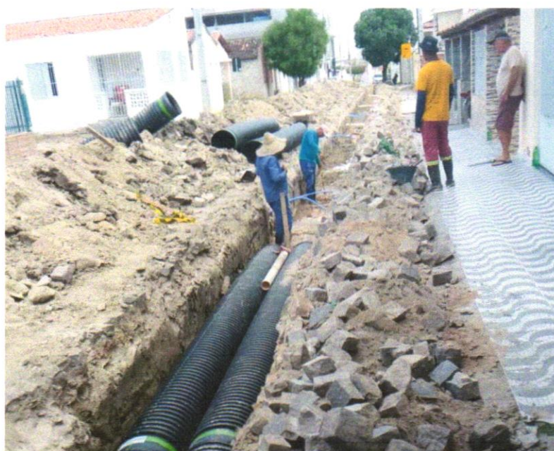
Foto 03 - ESCAVAÇÃO DE VALA
