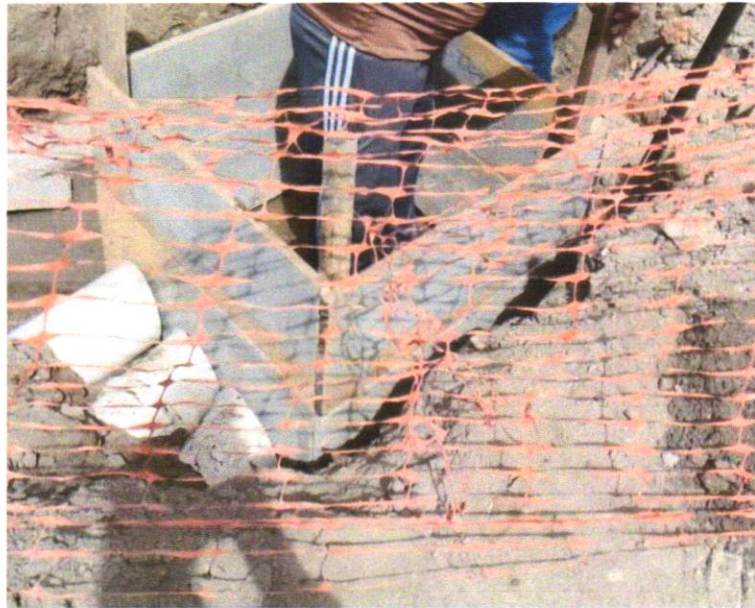
Foto 01 – Tapume de proteção em tela de polietileno h=1,20 com bloco de concreto
